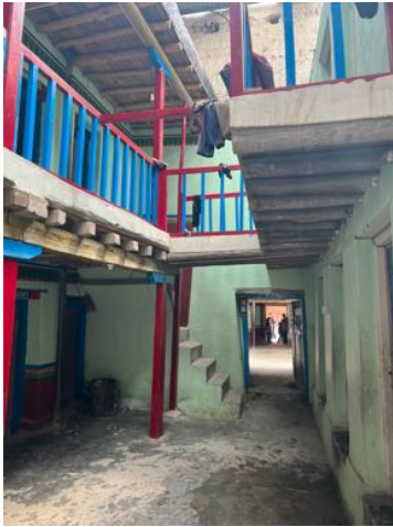
Die Schule im neuen Glanz nach den Malerarbeiten.
